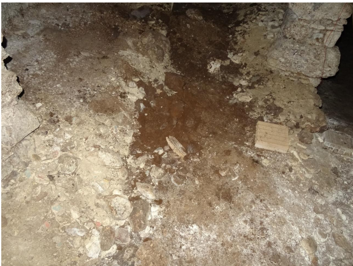
Aumento del crollo da sfaldamento nella "cavità A" già repertata in documentazione originaria nella foto A2
