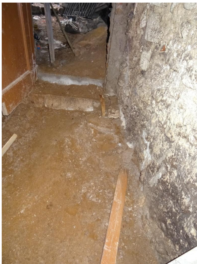
Aumento del crollo da sfaldamento nella "cavità A" già repertata in documentazione originaria nella foto A2
